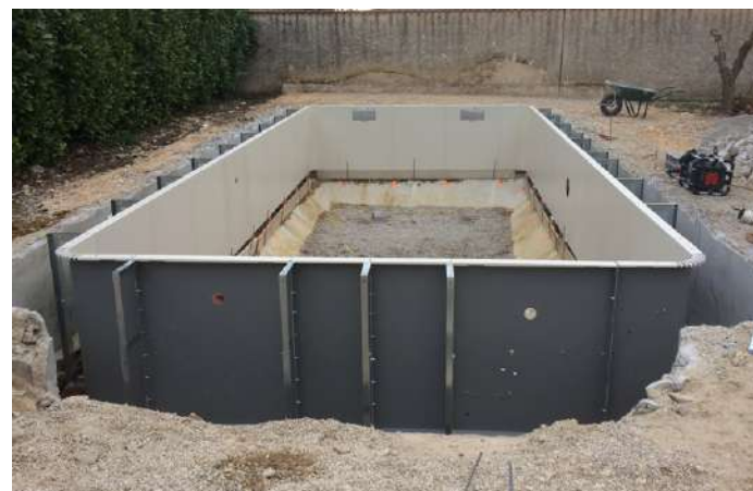
Structure d'une piscine Aquilus avec jambes de force « échelle »
